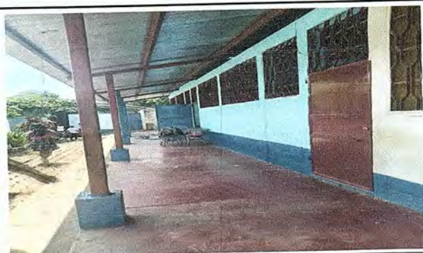
Foto 5: Pintura de interiores y exteriores. Pintura acrilica y aceite.
