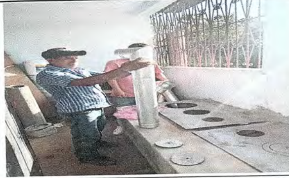
Foto 2: Sustitucion de estufa rural (completo).
