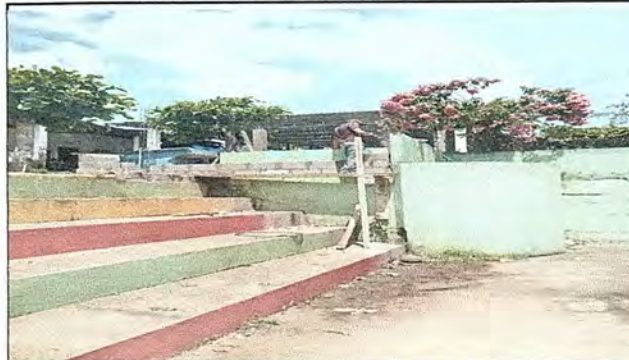
Foto 2: Muro perimetral de block y malla.
