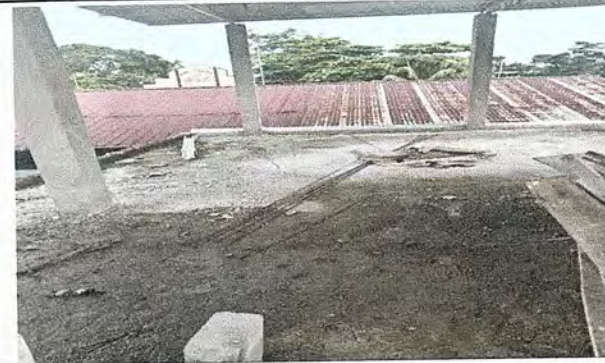
Foto 4: Sustitucion de piso por piso cerámico.
