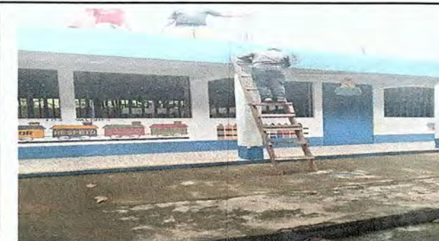
Foto 5: Pintura de interiores y exteriores. Pintura acrílica y aceite
