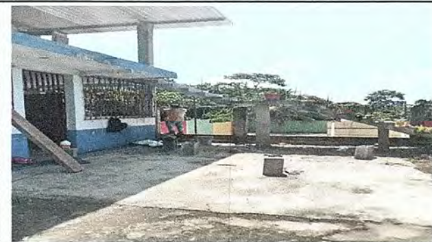
Foto 3: Muro perimetral de block y malla.
