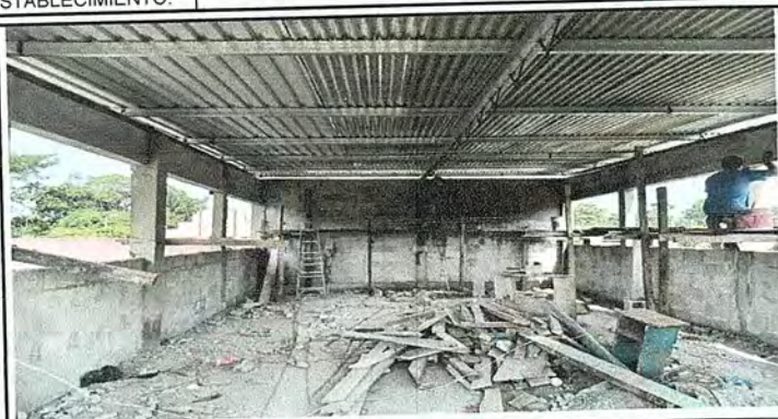
Foto 1: Sustitucion de lamina troquelada Aluzinc calibre 26.
