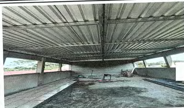
Foto 2: Sustitucion de piso, por piso cerámico
