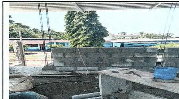
Foto 6: Muro perimetral de block.
