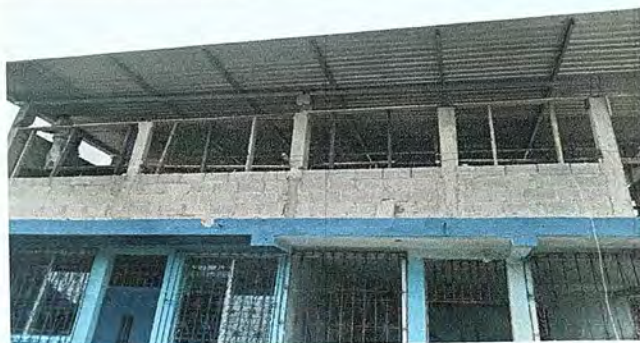
Foto 5: Reparacion de muro perimetral.
