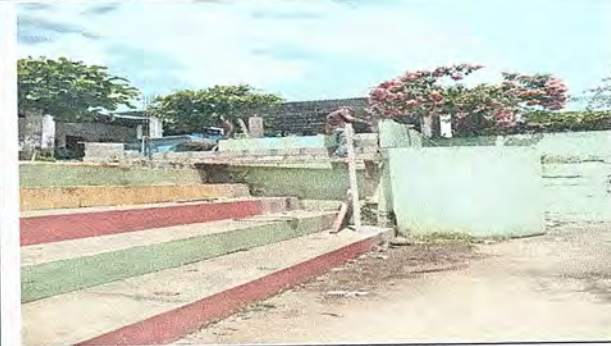
Foto 6: Muro perimetral de block y malla.
