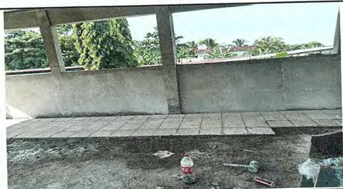
Foto 3: Sustitucion de piso, por piso cerámico.
