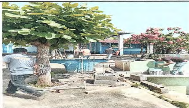
Foto 1: Muro perimetral de block y malla.
