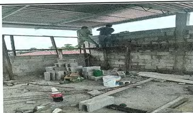
Foto 6: Reparacion de muro perimetral.
