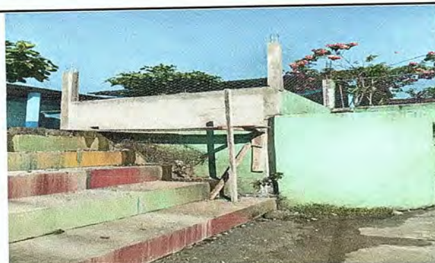
Foto 4: Muro perimetral de block y malla.
