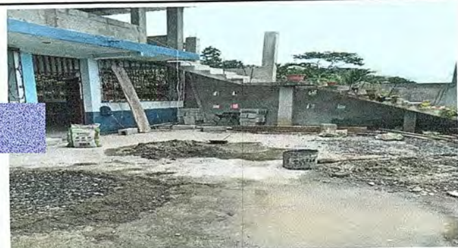
Foto 3: Muro perimetral de block y malla.
