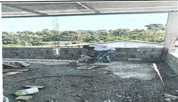
Foto 5: Sustitucion de piso por piso cerámico.
